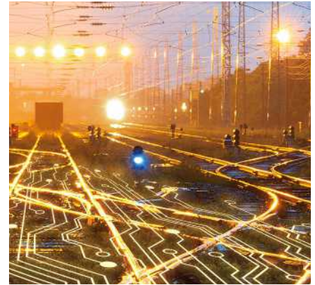
Aşırı gerilim korumalı modern demiryolu altyapısı
